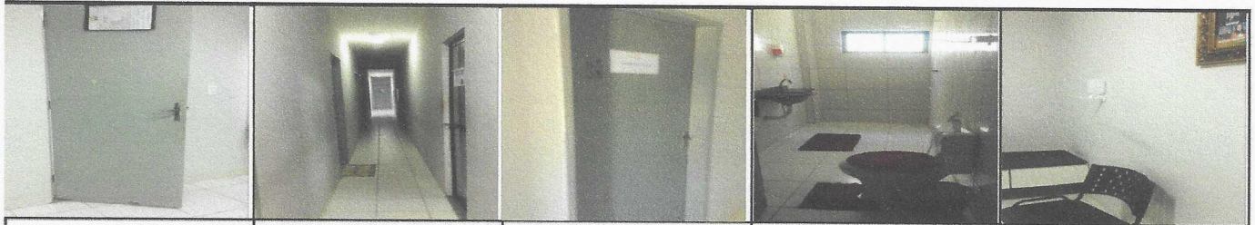
TRATAMENTO DE PINTURA
